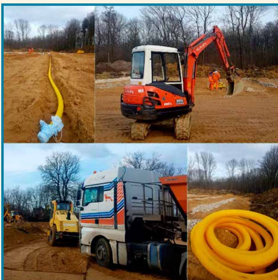
Przebudowa stadionu w Kobierzycach – etap I
