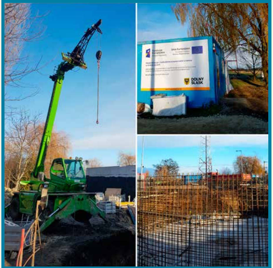
Modernizacja i rozbudowa oczyszczalni ścieków w Kobierzycach
