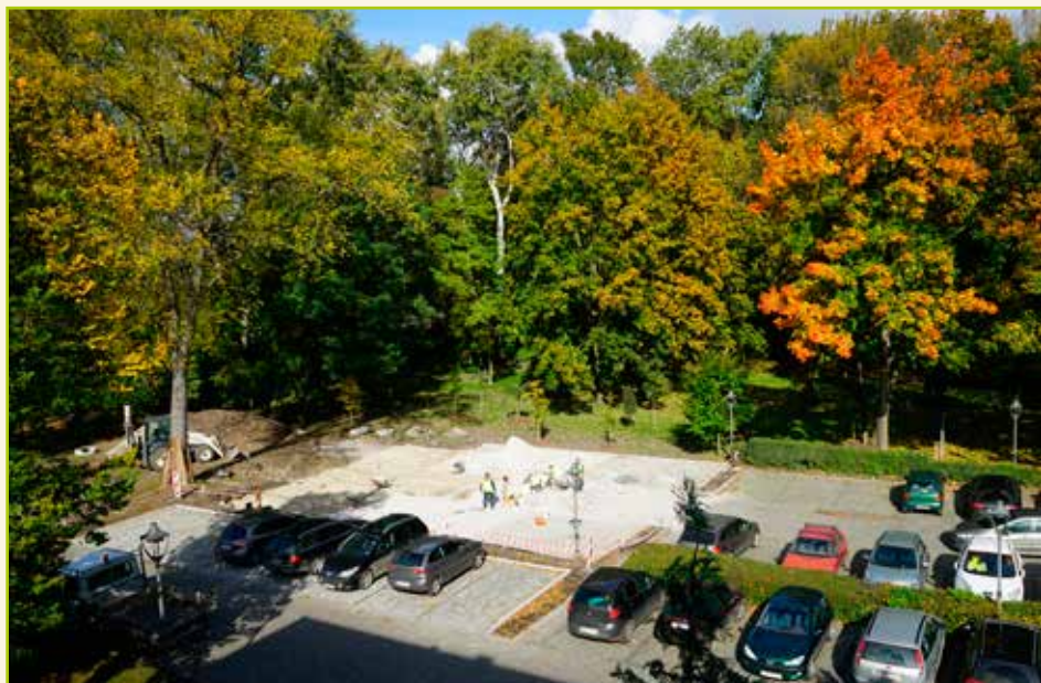
Budowa parkingu przy Urzędzie Gminy
