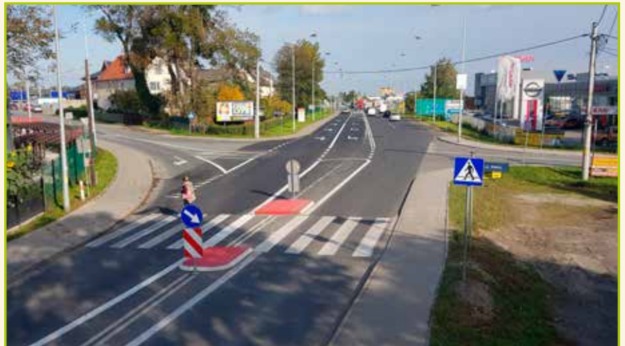
Przejście dla pieszych już jest używane
