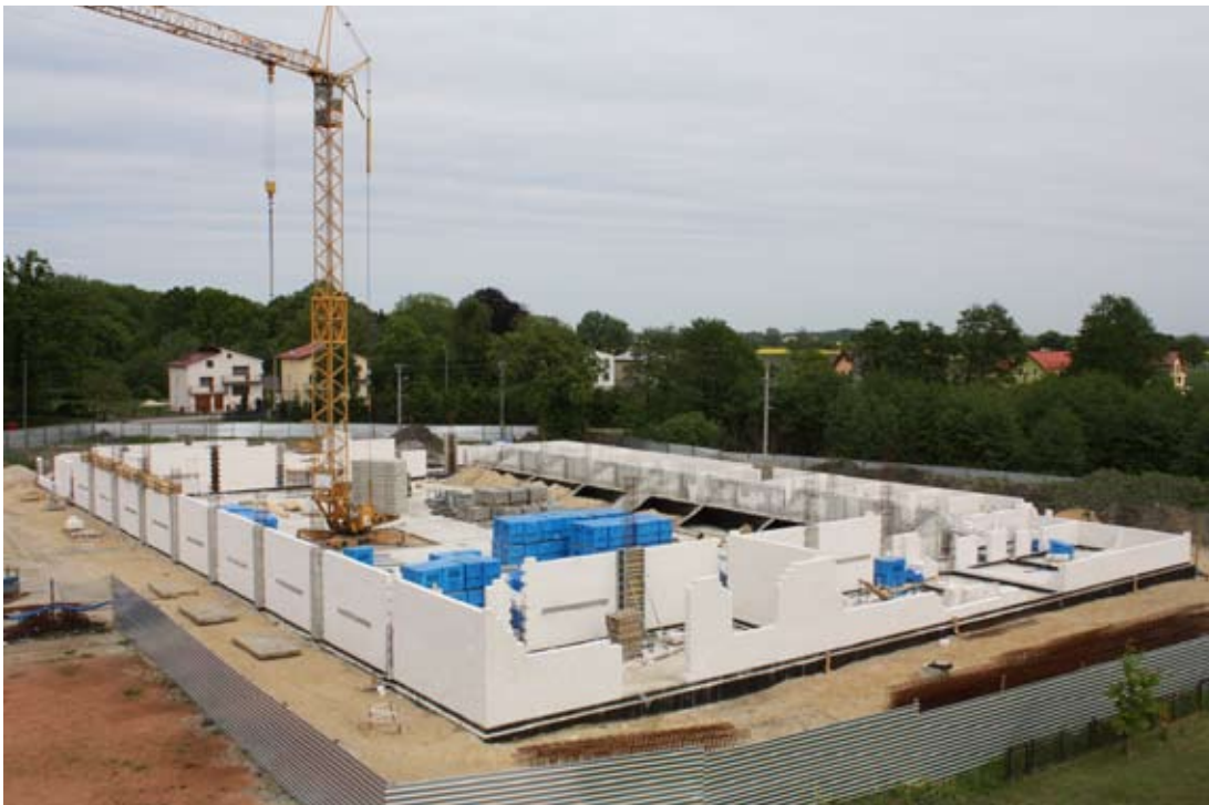
Hala w budowie maj 2009.
