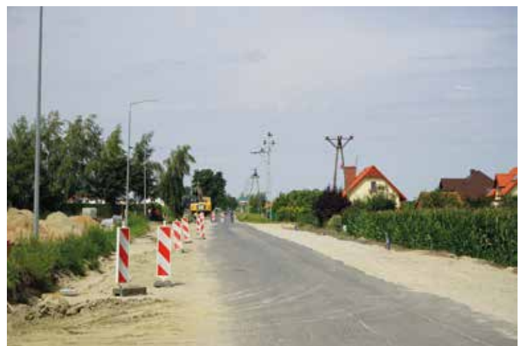
Przebudowa drogi w Królikowicach
