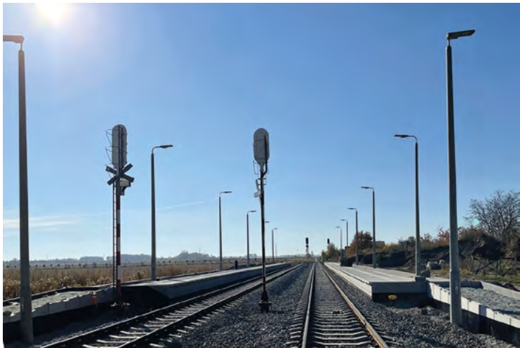
Linia kolejowa w Gminie Kobierzyce
