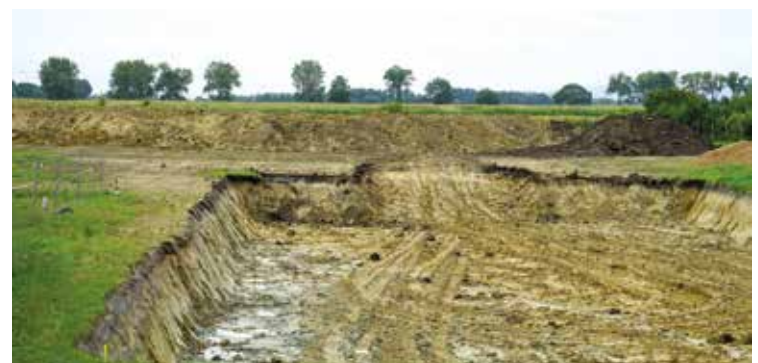
Rozpoczęła się budowa oczyszczalni ścieków w Kobierzycach
