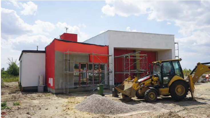
Budowa remizy strażackiej w Pustkowie Żurawskim
