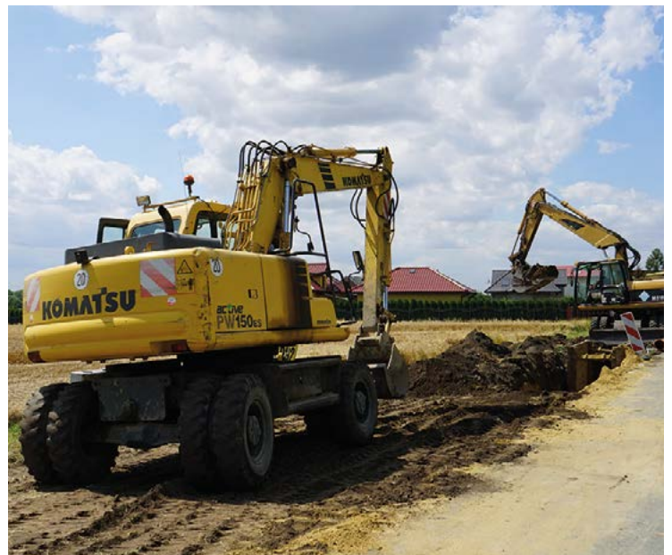
Budowa kanalizacji w Chrzanowie
