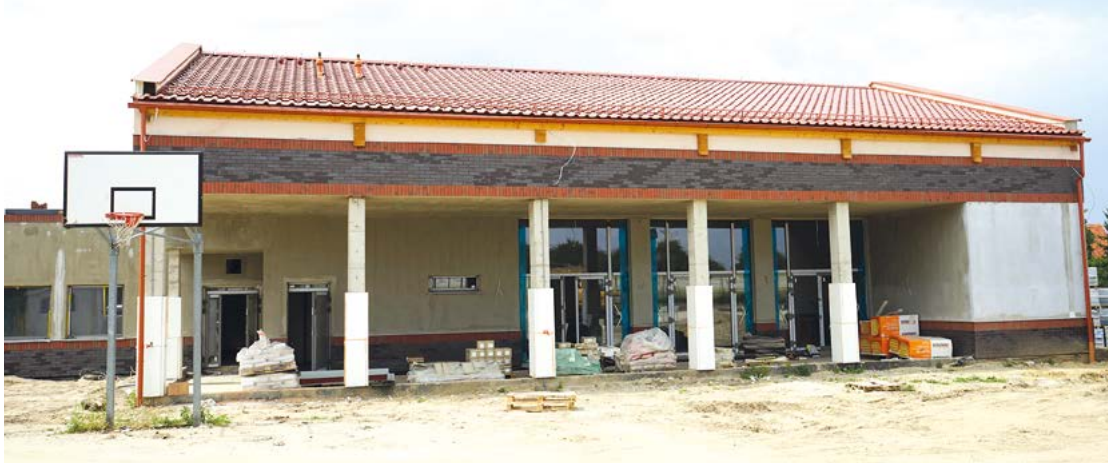
Budowa świetlicy w Ślęzie
