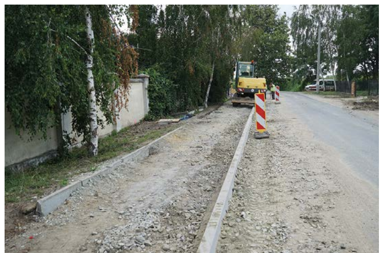
Odbudowa chodników po wykonaniu kanalizacji w Pełczycach
