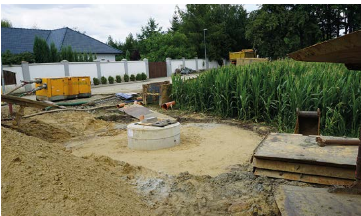
Budowa przepompowni ścieków w Pełczycach
