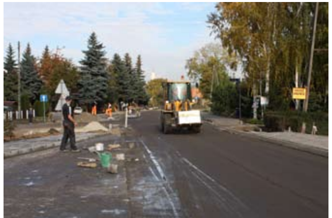
Kobierzyce - trwa budowa ul. Robotniczej
