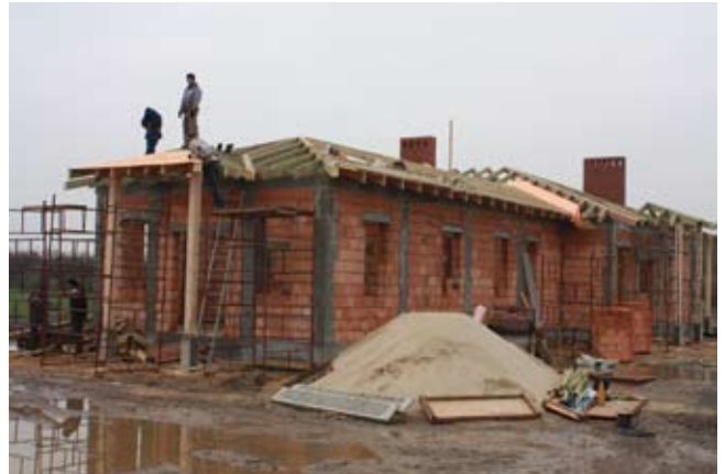
Małuszów - budowa świetlicy
