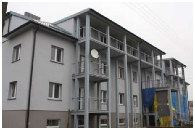
Pustków Żurawski - prace wykończeniowe w byłym hotelu
