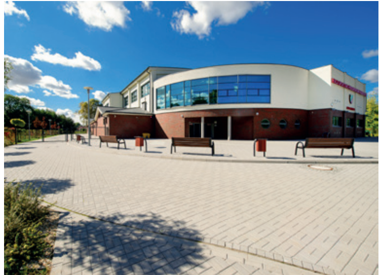
Hala Sportowo-Widowiskowa w Kobierzycach
