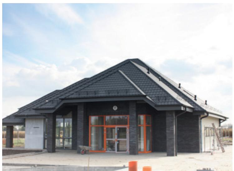
Świetlica w Cieszycach - w trakcie budowy
