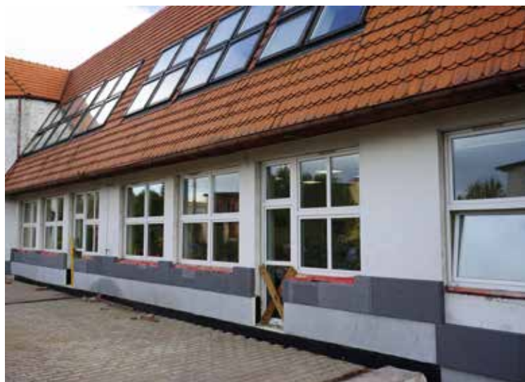
Docieplanie elewacji w szkole w Kobierzycach
