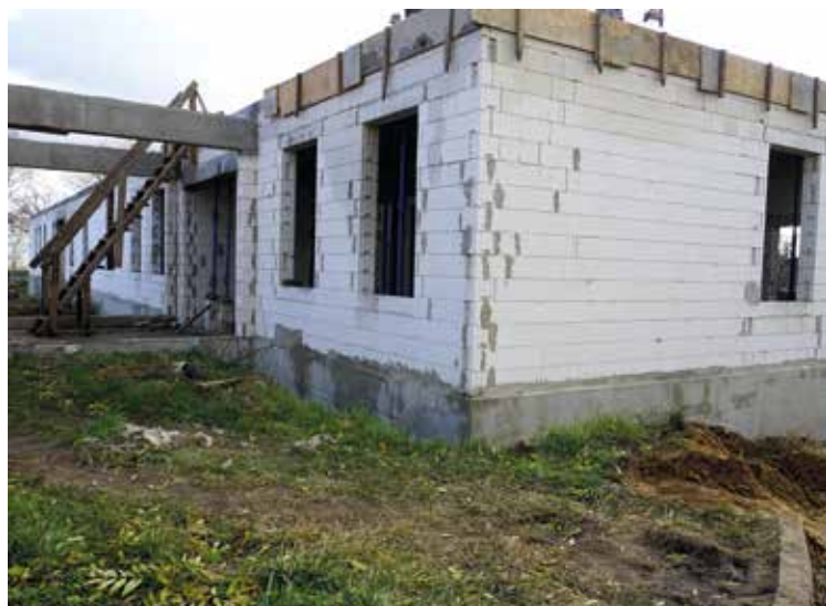
Budowa ośrodka zdrowia w Kobierzycach
