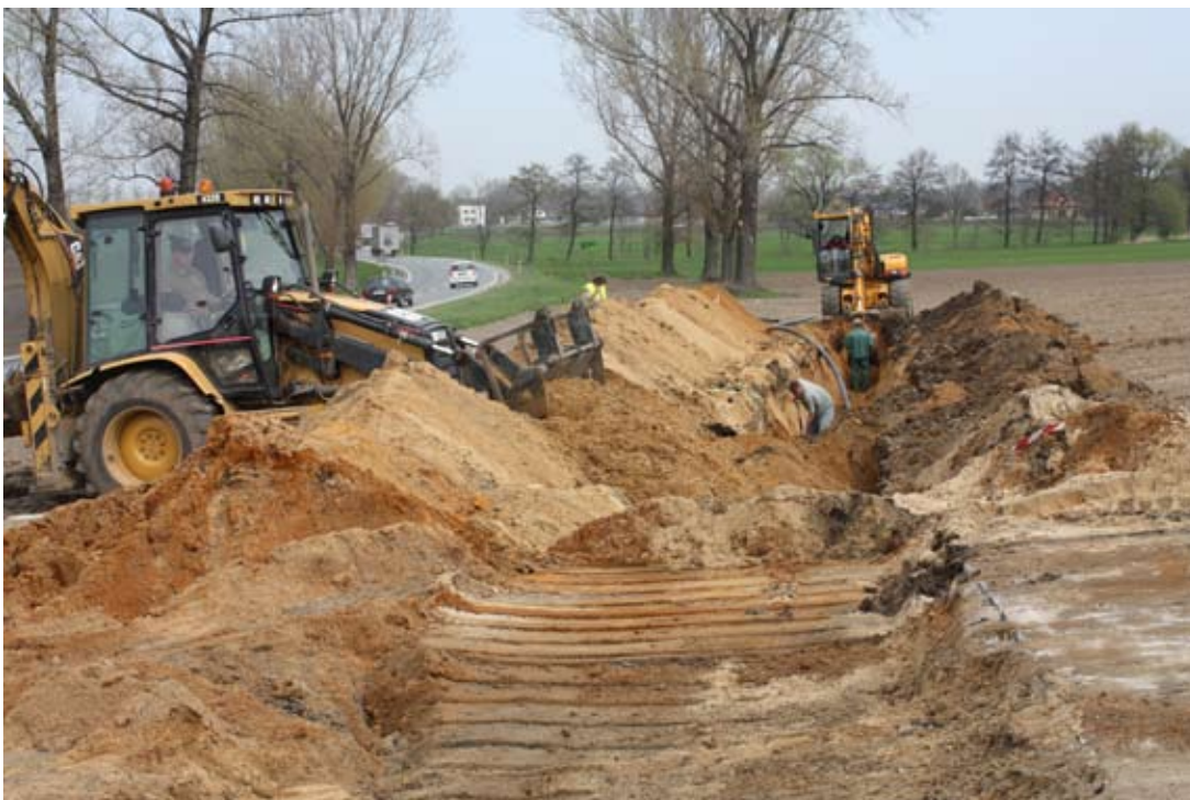
Budowa kanalizacji w Rolantowicach
