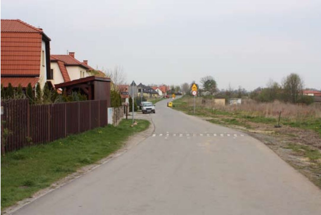
Nakładki bitumiczne w Bielanych Wrocławskich
