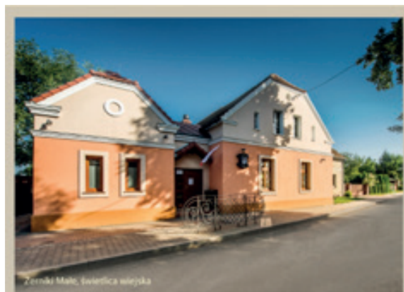
Żerniki Małe, świetlica wiejska
