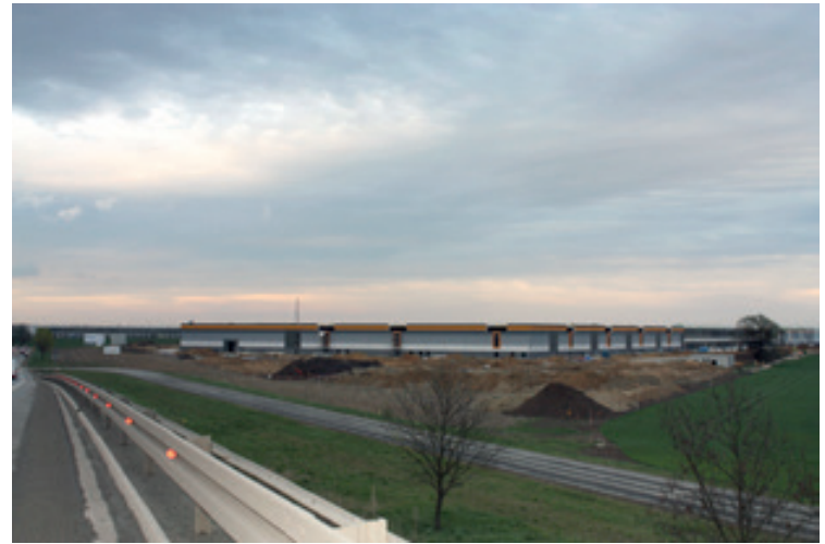
Budowa firmy Amazon
