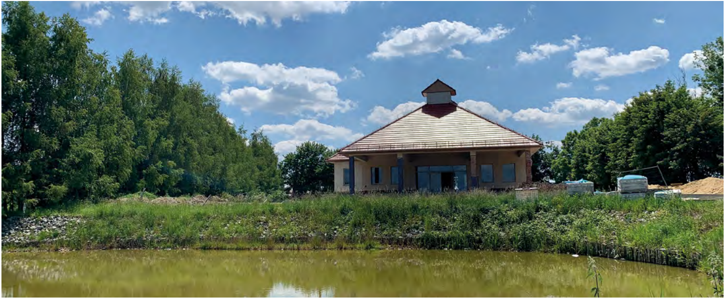
Księginice - budowa świetlicy
