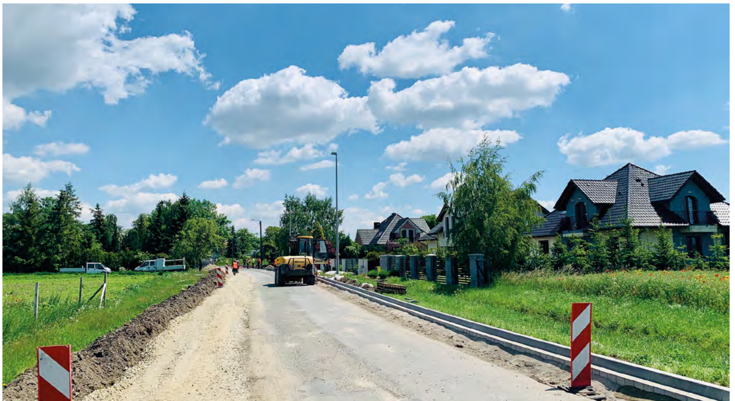
Rolantowice-Dobkowice-Damianowice - budowa drogi
