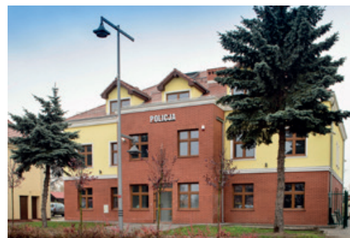
Budynek przy ul. Witosa 11 fot. M. Mazurkiewicz
