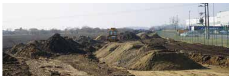
Prace ziemne w „Węzle Bielańskim”
