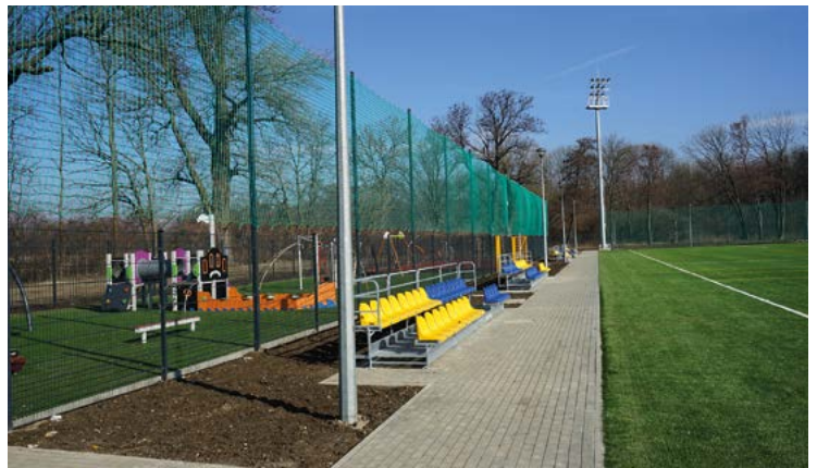
Zamontowano też krzeselka (stadion w Kobierzycach)
