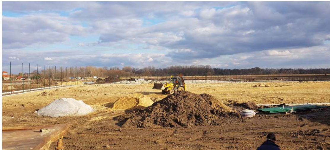
Trwa budowa obiektów sportowych w Ślęże
