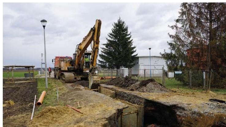
Budowa kanalizacji w Księginicach
