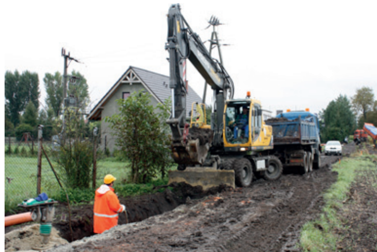
Prace przy budowie kanalizacji w toku
