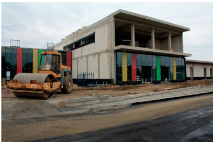
Budynek Zespołu Szkolno-Przedszkolnego w Tyńcu Małym w trakcie realizacji
