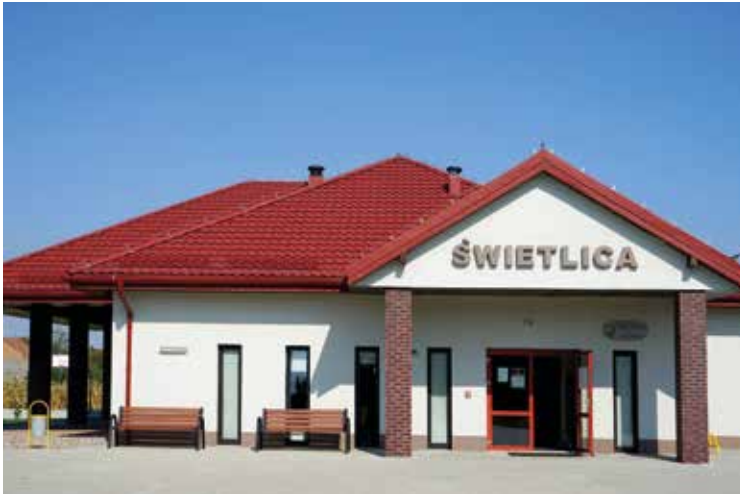
Jaszowice – świątlica wiejska
