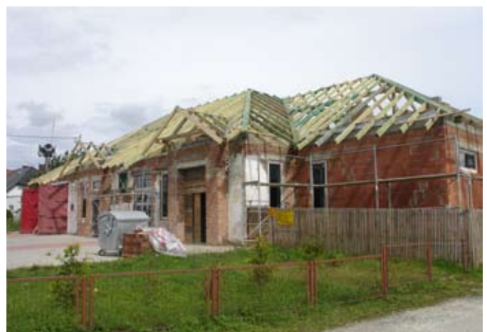
Budowa świetlicy w Pustkowie Wilczkowskim
