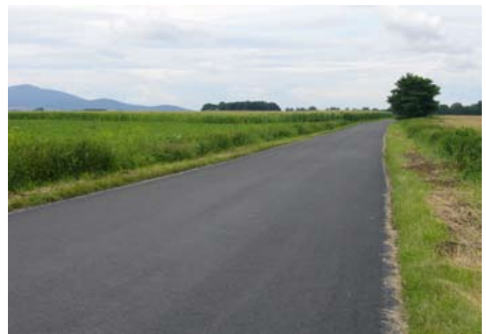
Nakładka bitumiczna na drodze Wierzbice- Solna
