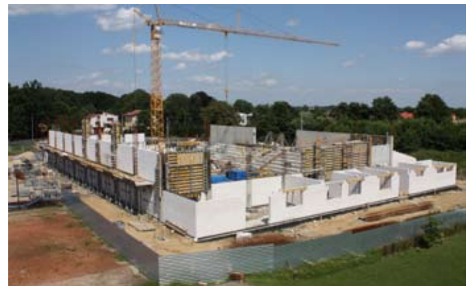
Budowa hali sportowo-widowiskowej w Kobierzycach
