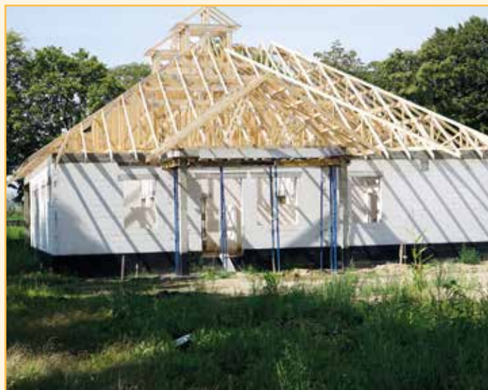
Budowa świetlicy w Kuklicach
