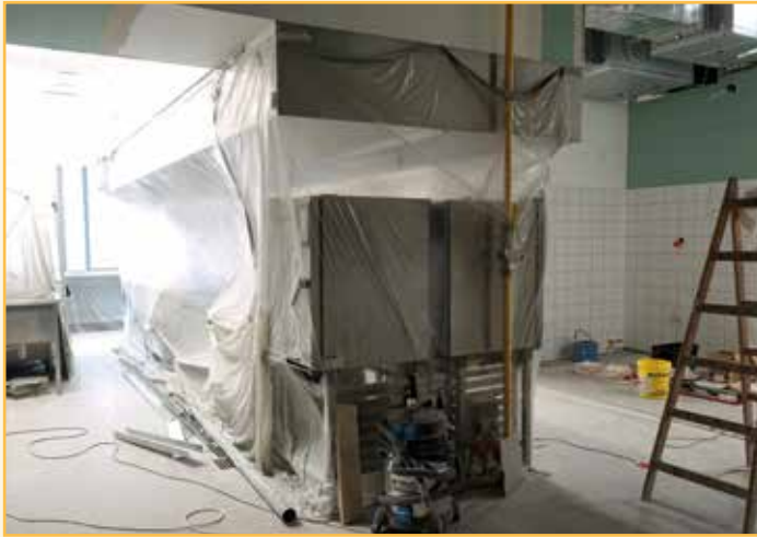
Rozbudowa kuchni w szkole w Wysokiej
