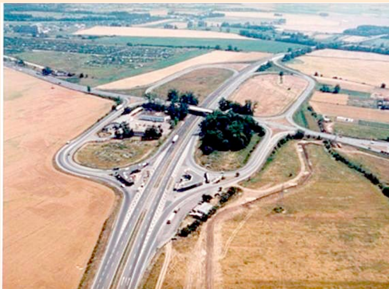
Tak wyglądał Węzeł Bielański przed pojawieniem się inwestorów....
