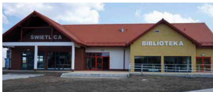
Świetlica w Tyrńcu nad Ślężą
