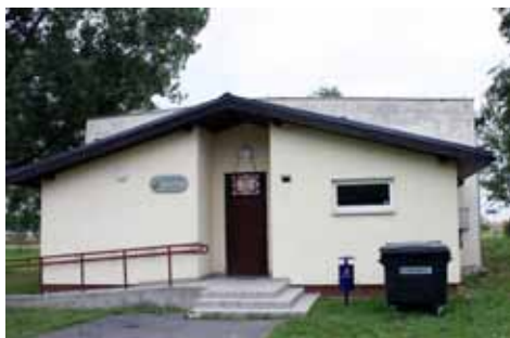
Świetlica w Dobkowicach
