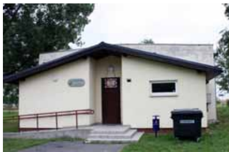
Świetlica w Dobkowicach
