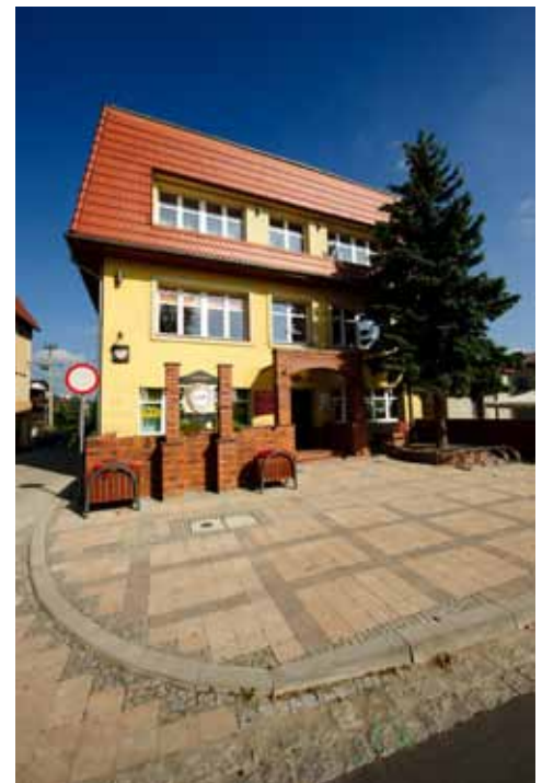
Budynek Gminnego Ośrodka Pomocy Społecznej w Kobierzycach, fot. Marcin Mazurkiewicz
