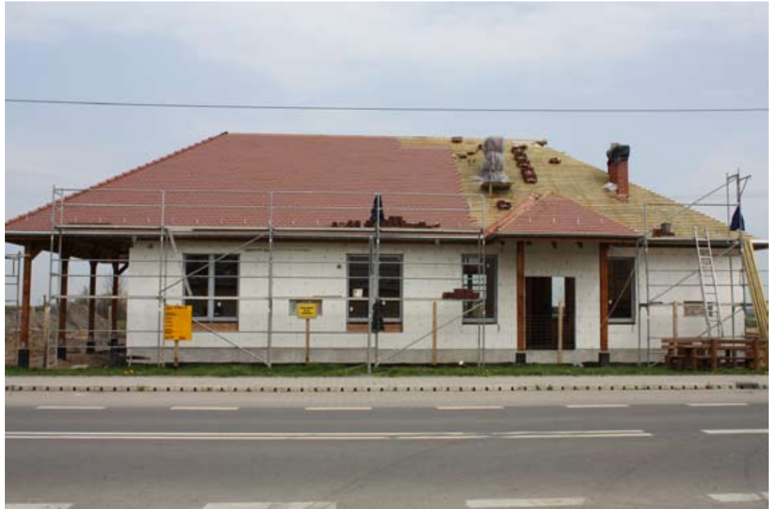
Budowa świetlicy w Szczepankowicach
