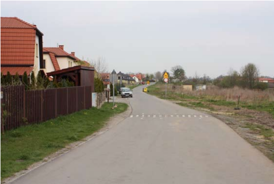
Nakładki bitumiczne w Bielanych Wrocławskich
