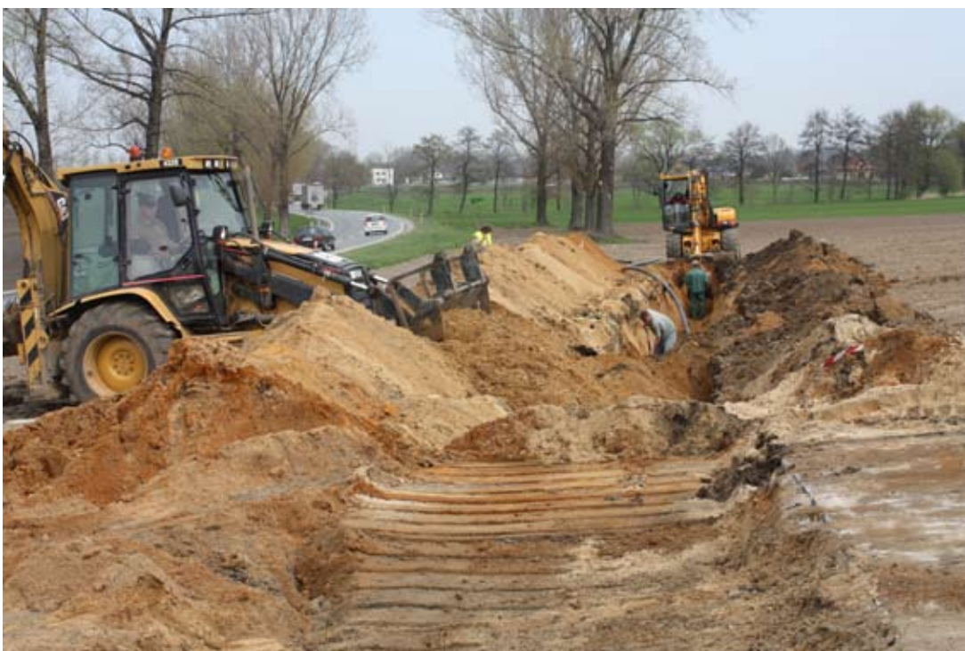
Budowa kanalizacji w Rolantowicach
