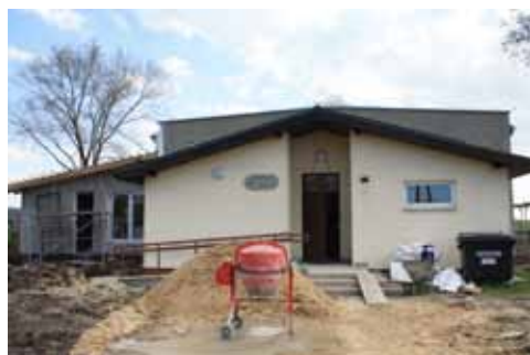
Świetlica w Dobkowicach
