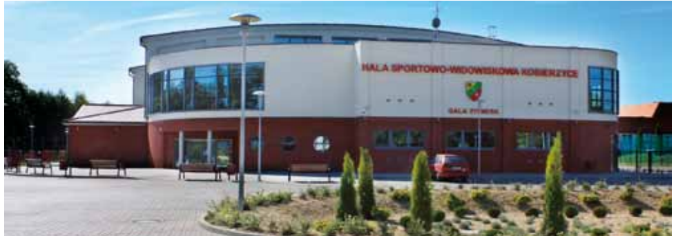
Hala sportowo-widowiskowa w Kobierzycach
