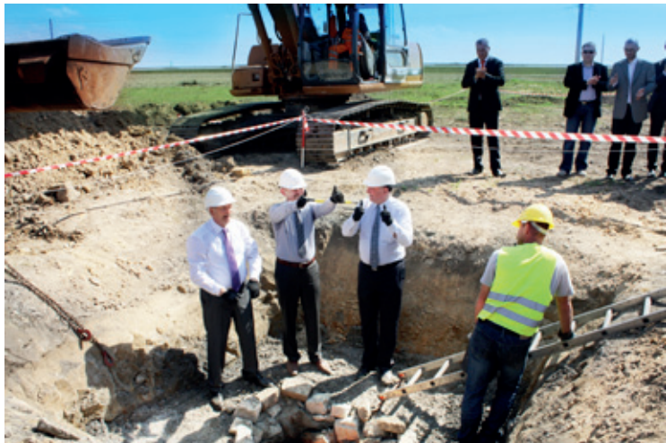
Początek budowy nowej siedziby firmy Lapp Kabel
