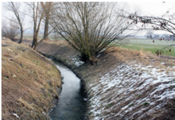
Rzeka Sławka po wykonaniu konserwacji przez Gminną Spółkę Wodną
