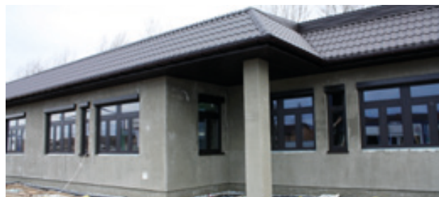
Rozbudowa budynku Gminnego Zespołu Szkół w Bielanych Wrocławskich
