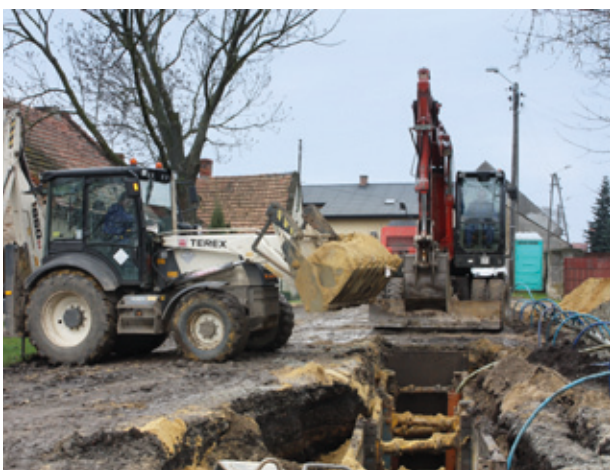
Budowa sieci kanalizacyjnej w Owsiance
