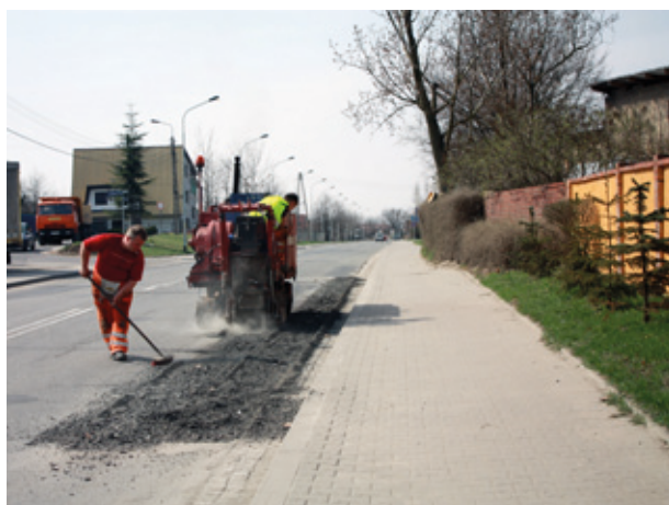
Naprawa nawierzchni drogi w Tyńcu Małym
